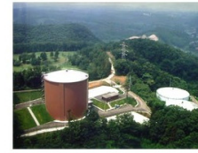
①高本山配水場 ・市配水池(S41.6完成) PCタンク 1,800m 3 × 2池 高さHWL=102.0m/水深4.0m ・県配水池(S62.3完成) PCタンク 8,600m 3 × 1池 高さHWL=125.0m/水深20.0m
