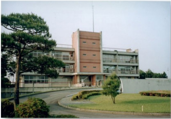
水道庁舎(S49.3完成) 管理棟(RC)3階建 1,364.3m 2 ・第1浄水場(S39.10完成) 取水能力: 8,530m 3 /日 ・第2浄水場(S49.3完成) 取水能力: 7,700m 3 /日 配水池(RC)4,000m 3 × 2池
