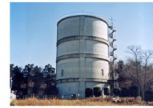
⑥腰塚配水場(S54.12完成) ・高区(PCタンク)830m 3 高さHWL=80.6m/水深4.7m ・低区(PCタンク)520m 3 高さHWL=73.9m/水深3.0m ・受水池(PCタンク)650m 3 高さHWL=62.5m/水深3.9m
