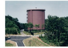
③高坂高区配水場(S55.10完成) ・PCタンク 2,700m 3 高さHWL=112.6m/水深=15.5m ④高坂丘陵配水場(S59.3完成) ・PCタンク 900m 3 高さHWL=73.1m/水深=5.1m
