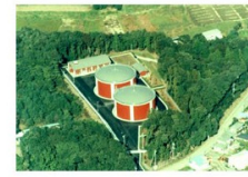
②水穴配水場(H10.10完成) PCタンク 6,900m 3 × 2池 高さHWL=55m/水深13m 配水ポンプH=33m
